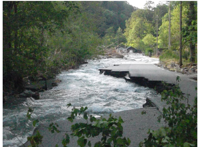
Écroulement de la route de Luchon à l'Hospice de France (31) Photo : Xavier Basseras
